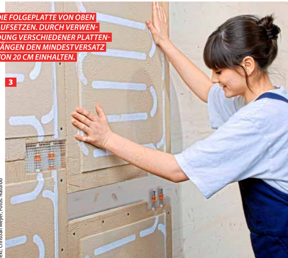
1 Die Platten durch die Flachkanten mit der Wand verschrauben oder – auf mineralischen Untergründen – verkleben.
