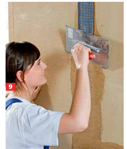
9 Die Flachkanten dann mit etwas Überstand verspachteln und dabei auf eine gute Verdichtung achten.
