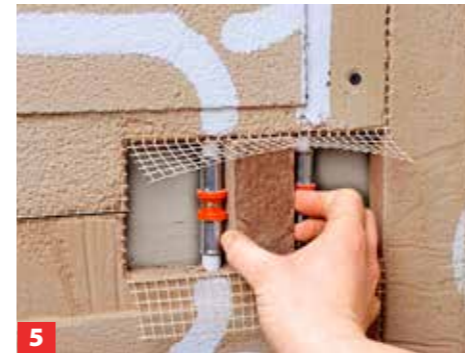
4 Die Rohre der oberen Platte entgraten und sauber auf die Presskupplungen der unteren Platte aufsetzen.
