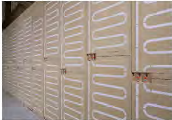
Die naturbo therm-Endplatte entspricht dem klassischen Aufbau einer Wandheizung. Sie ist dazu angelegt, das Wasser an der Unterkante aufzunehmen, über Schlaufen nach oben und im Kreis zurück nach unten ins Rücklaufsystem der Heizung zu führen. Es gibt sie in 3 Größen mit 115 cm, 95 cm oder 55 cm Höhe. Das naturbo therm Wandheizungssystem funktioniert als Baukastenprinzip. Damit kann die Höhe der Wandheizung flexibel dimensioniert werden. Gleichzeitig können die vergleichsweise leichten Platten von einem Mann getragen werden (20 bis 25 kg pro Platte). Foto: naturbo
