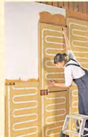
Wandflächenheizungen sind ein ideales Heizsystem für Wärmepumpen, da sie mit ihren Vorlauftemperaturen die Effizienz der Wärmepumpen vervielfachen.
