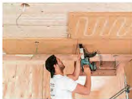
Vorgefertigte Flächenheizungselemente mit wohngesundem Lehmputz lassen sich schnell und einfach einbauen.
