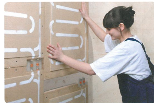
Einfacher Anschluss und Verschraubung der Elemente. Quellen: WEM
