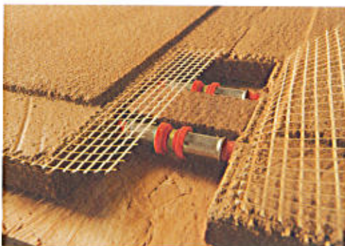
2 Mit Presskupplungen werden die Heizungsrohre der Wandheizungsplatten sicher verbunden.
