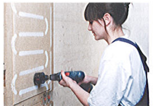
6 Dank des gekennzeichneten Verlaufs der Heizrohre außen können zum Beispiel Unterputzsteckdosen bis 68 mm einfach positioniert werden.
