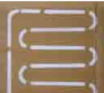
Platte mit markiertem Verlauf der Heizschlangen
