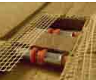
Verbindung der Platten durch Presskupplungen
